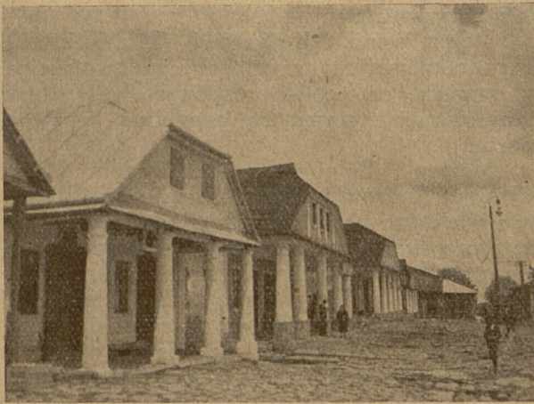
Charakterystyczne domy z podcieniami na rynku w Podkaminie.
