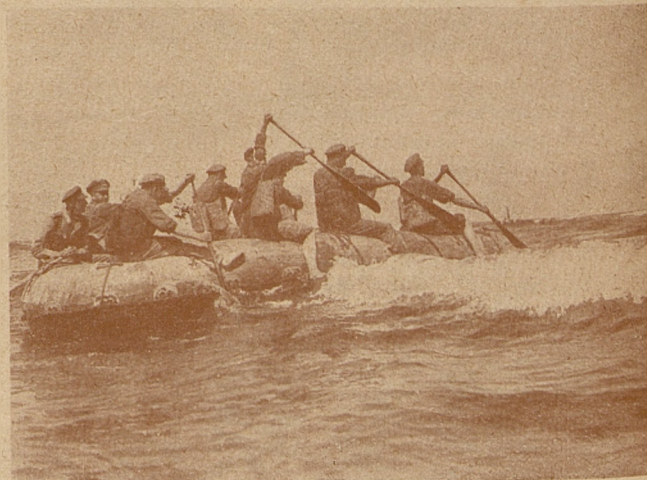
Na wybrzeżu morza, w okolicy Swinemünde (Niemcy) bataljon pionierów przeprowadził ćwiczenia na specjalnych pływakach napełnionych powietrzem.
