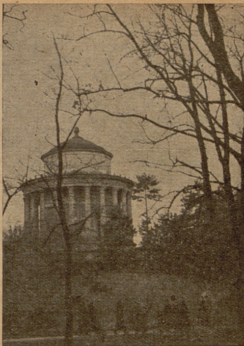
Przed kilkudziesięciu laty mieścił się tu zbiornik wody. Dzisiaj — wobec rozbudowy nowoczesnej sieci wodociągowej — jest niepotrzebny i stoi pusty.
