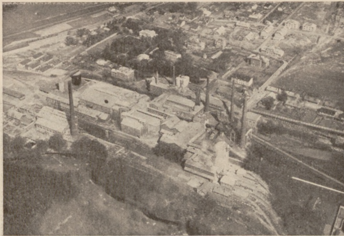
Widok Fabryki Portland-Cementu „Szczakowa“
