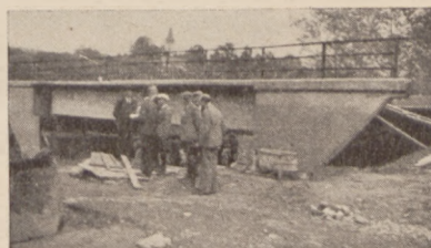
Most żel. betonowy 14,00 m. światła
