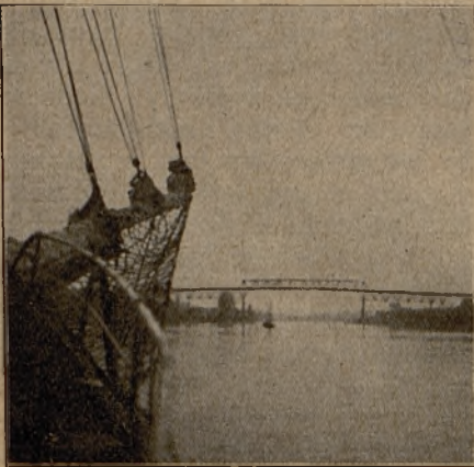
Most nad kanałem kilońskim.
