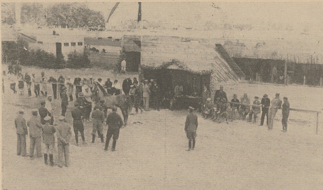
KONIN. Komisja remontowa przy pracy.
