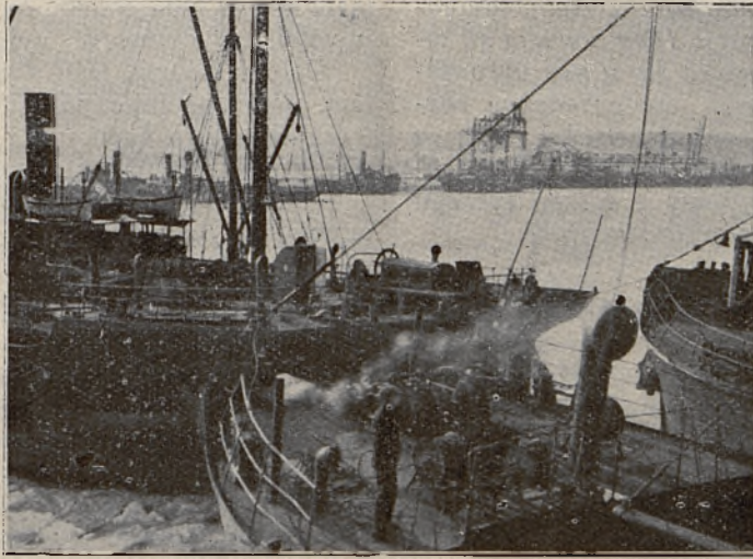
Już zdaleka widać sylwety urządzeń technicznych portu gdynińskiego.
