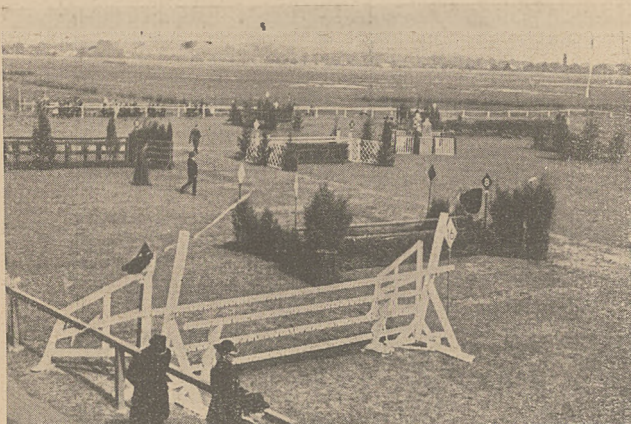
Łódź. Ogólny widok toru.
