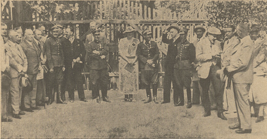
Przed otwarciem pokazu koni remontowych w Szamotułach.
