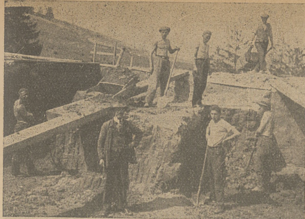
W Ustrzykach Dolnych strzelcy przystąpili do budowy ochronki dla dzieci.
