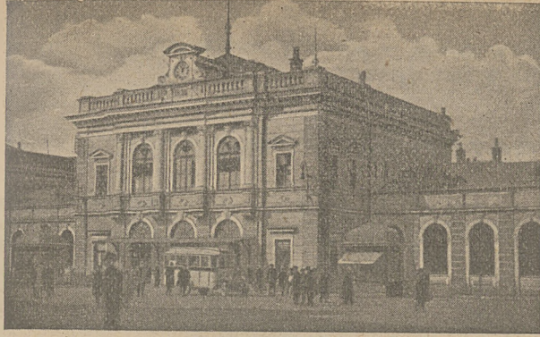
Dworzec Kolejowy w Przemyślu.
