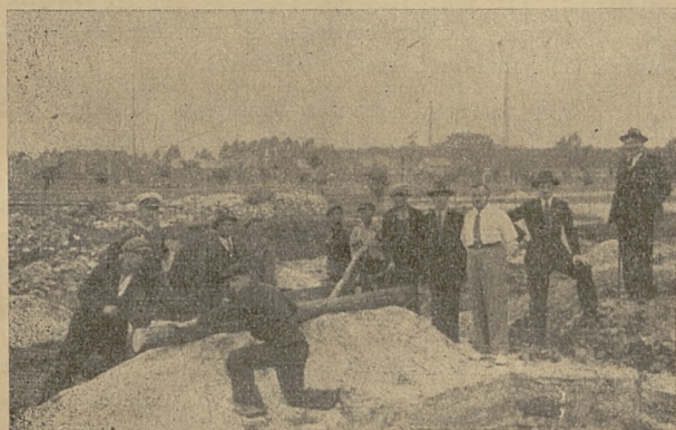
Prace przy budowie Domu Strzeleckiego w Niwce.
