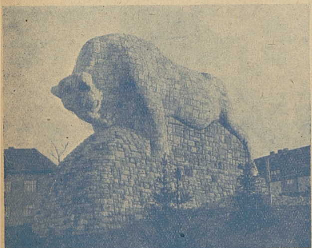
Olbrzymi posąg zebra, w jednej z dzielnic Berlina zbudowany jest z drobnych kawałków kamienia.
