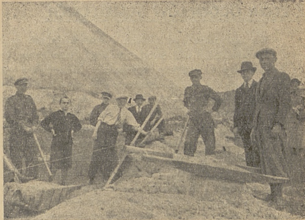
Strzelcy przy budowie strzelnicy O. Z. S. Huta Katarzyna w Sosnowcu.
