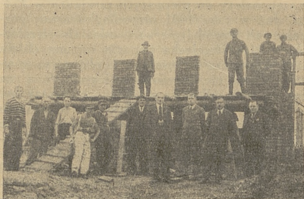
Budowa Domu Strzeleckiego w Niwce.
