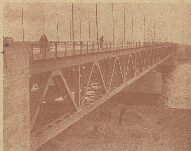
Nowy most na jednej z nowowypbudowanych autostrad niemieckich pod Magdeburgiem.
