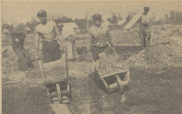
Strzelcy z Bielska Podl. pracują przy budowie bieżni na boisku sportowym.
