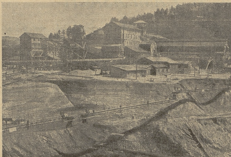
Teren budowy zapory w Rożnowie.
