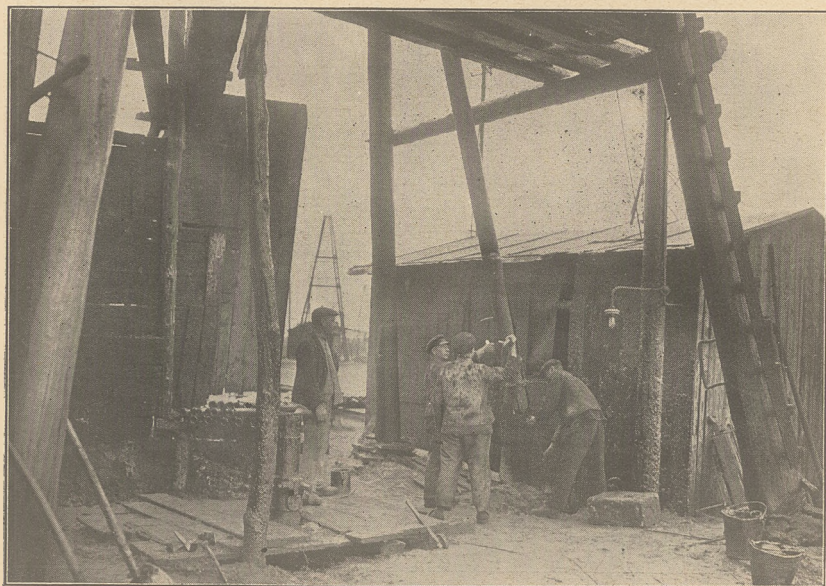
Prace przy wierceniu nowego szybu. Pierwsza gęsta i brudna ropa już trysnęła. Atlantic-Photo
