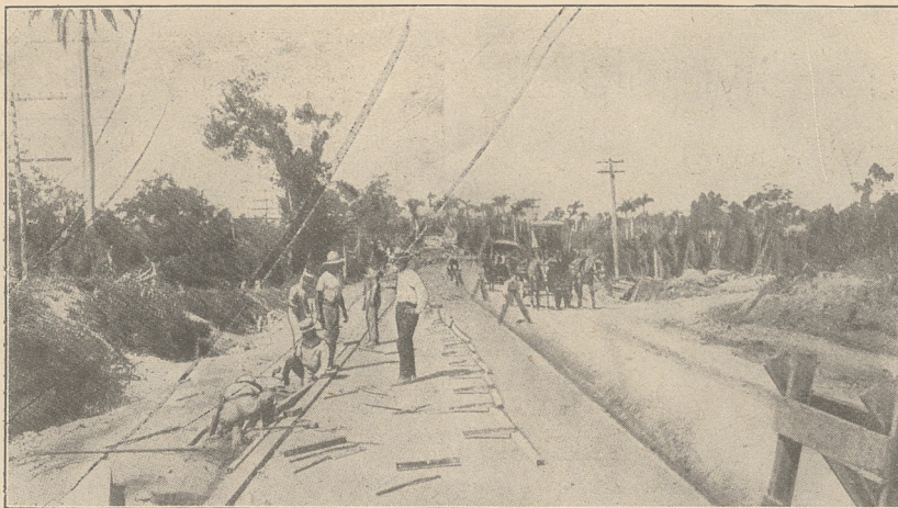
Budowa centralnej autostrady. Połowa szosy ma już fundamenty cementowe. Ruch pojazdów odbywa się na drodze polnej.
