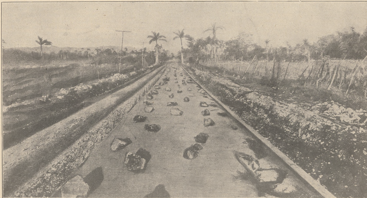
Podczas długotrwałego procesu gestnienia asfaltu szosa usłana jest gęsto kamieniami, broniącymi dostępu na niewykończoną jezdnię.
