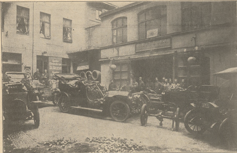
Pierwotne zakłady reparacyjne przy ul. Skarbowej cieszyły się wielką, jak na owe czasy, frekwencją. Zdjęcie z roku 1906.
