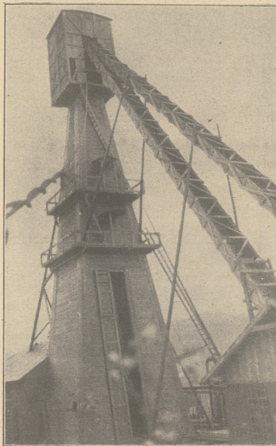
Wieża wiertnicza z dwoma korytami wyciągowymi, własność firmy „Galicja” w Borysławiu. Produkcja ca. 10 ton ropy na dobę i przeszło 20 metrów sześciennych gazu świetlnego na minutę.
