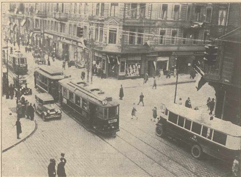
Skrzyżowanie jezdni placu Wolności z ul. Fr. Ratajczaka. Fot. „Samochód”
