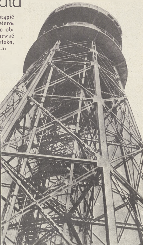
Dla zakotwiczenia sterowca-olbrzyma ustawiono na lotnisku Cardington potężny maszt w konstrukcji żelaznej. Metodę tę obrano z tego powodu, że wprowadzanie tak wielkiego statku do hangaru połączone jest z niezwykle trudnościami.
