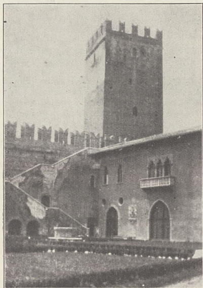
Jedną z najciekawszych budowli w Weronie jest Castelvecchio (stary zamek).
