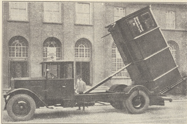
Charakterystyczne urządzenie hydrauliczne do automatycznego rozładowywania samochodu ciężarowego. Cylinder, w którym ciecz porusza silny tłok, oparty jest w przedniej części podwozia, a skrzynia spoczywa na zawiasach, umocowanych w tyle.
