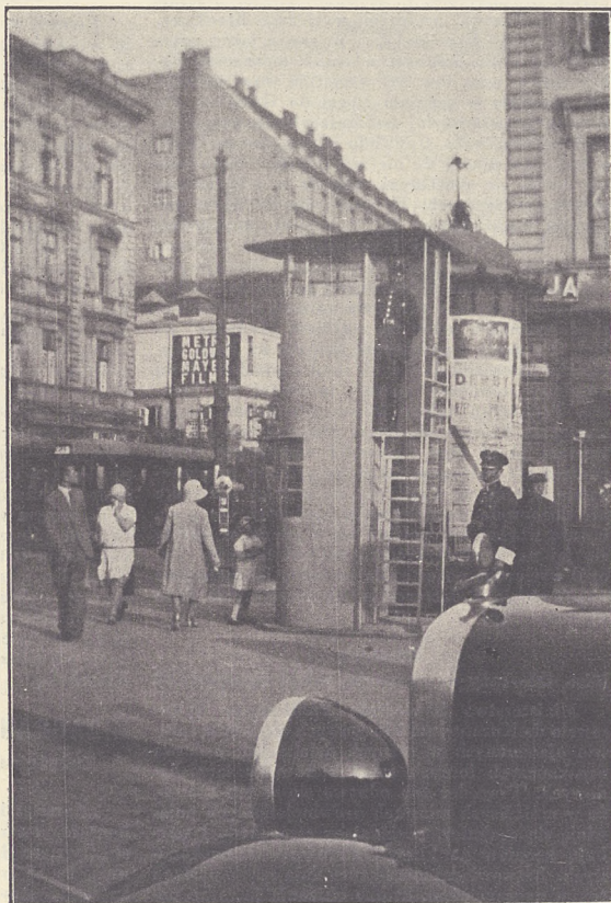
W Warszawie ustawiono przed Dworcem Głównym pierwszą wieżyczkę komunikacyjną, wykonaną całkowicie ze stali.
