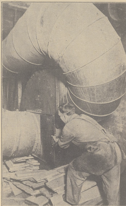
Olbrzymie, ogrzewane ekshaustory osuszają powietrze i regulują temperaturę w magazynach i suszarniach.
