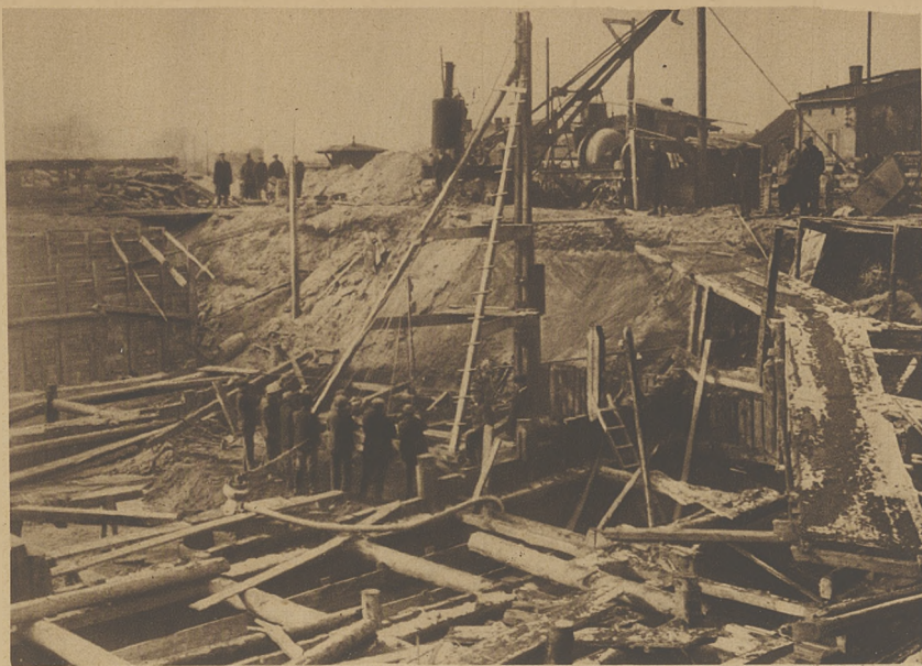
Wbijanie pali przy budowie tunelu na przejeździe katowickim w Sosnowcu.
