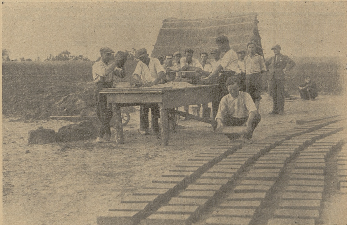
Strzelcy z Oddziału Rój pow. Rybnickiego postanowili własnymi siłami wybudować świetlicę. Na ilustracji: członkowie oddziału pracują przy wyrobie cegieł, z których wybudowana zostanie świetlica.
