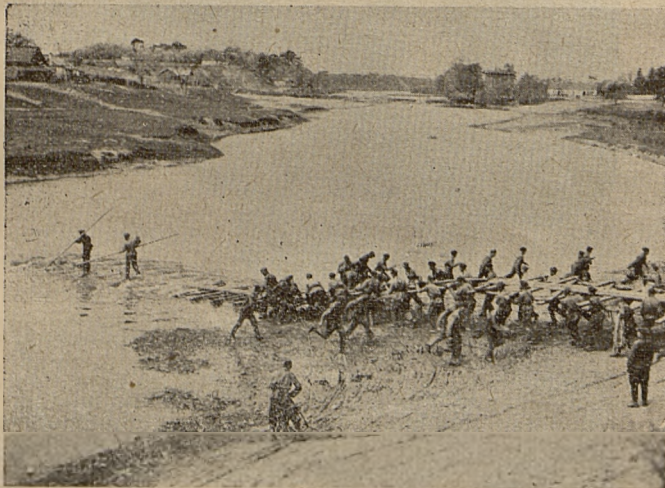
Wysuwanie kładki dla pieszych przez rzekę.
