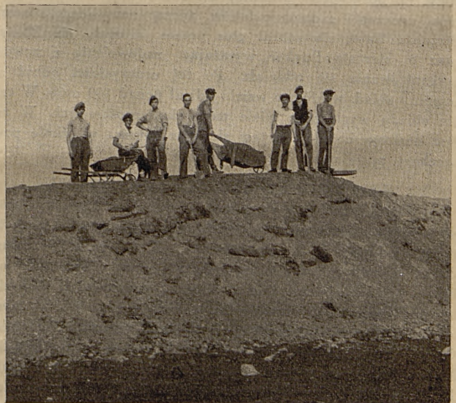
Strzelcy z Wyszkowa przy budowie strzelnicy.
