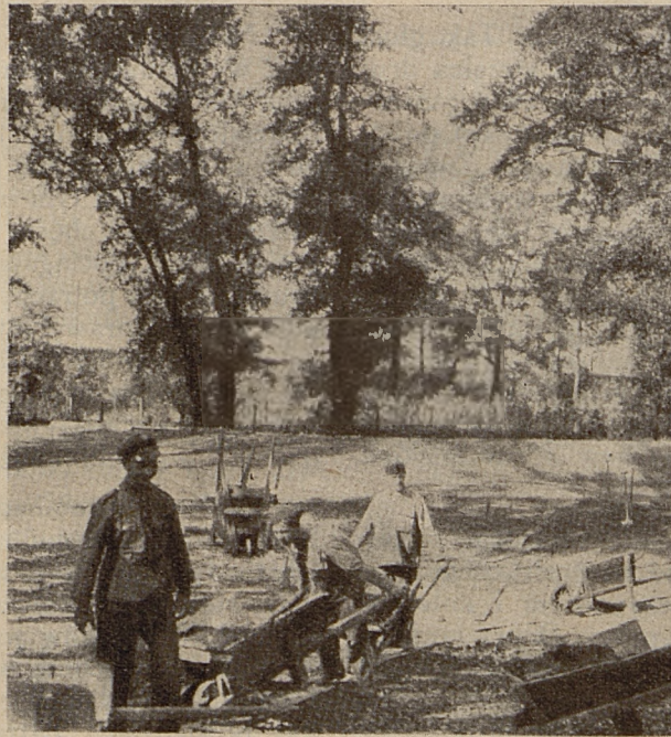
Strzelcy z warszawskiego obozu pracy przy robotach ziemnych w ogrodzie zoologicznym.
