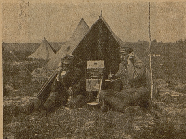
Stacja telefoniczna w polu.
