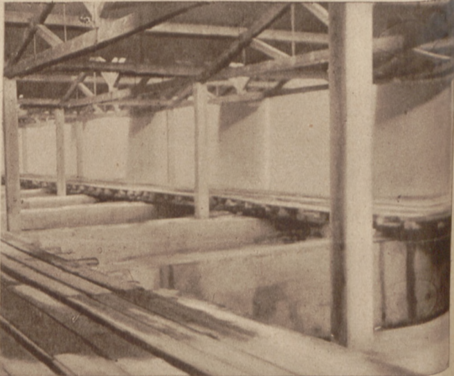
Filtry pod dachem przed napełnieniem balastem cyjnym.
