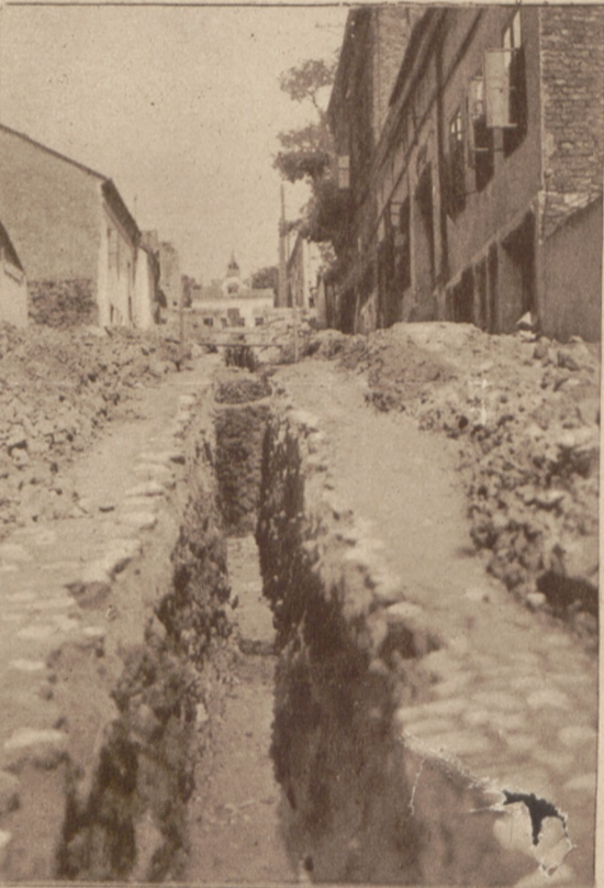
Wykop pod rury wodociągowe
