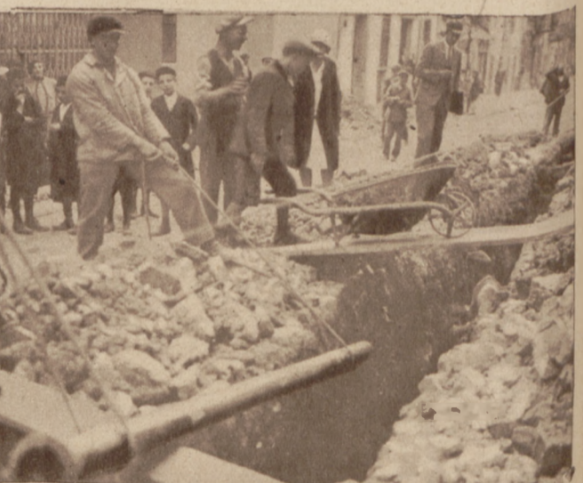
Opuszczanie rur do wykopu przy ul. Śto Jańskiej
