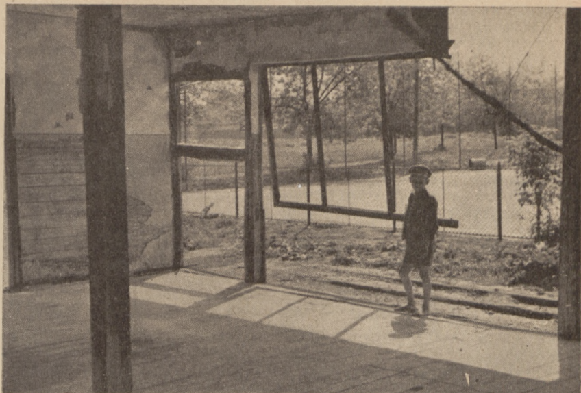
Unser Tennishaus vor dem Aufbau.
