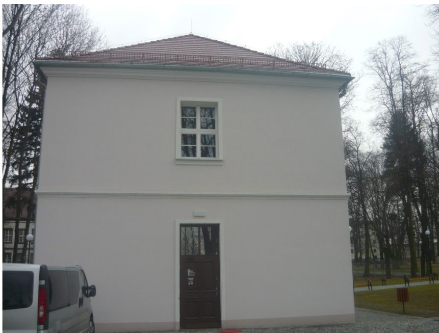
Wejście do biblioteki (fot. Agnieszka Hałubiec)
