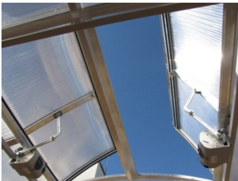
Otwierany dach dla teleskopu (z archiwum MiGBP w Nysie)
