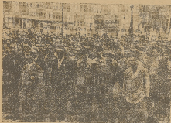
Na placu „9 września” w Sofii odbyła się odprawa pierwszej drużyny brygadierów wyjeżdżającej na miejsce pracy przy autostradzie.
