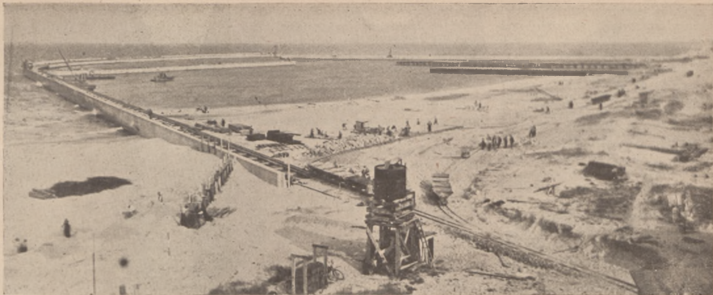
Budowa nowego portu rybackiego w Wielkiej Wsi.
