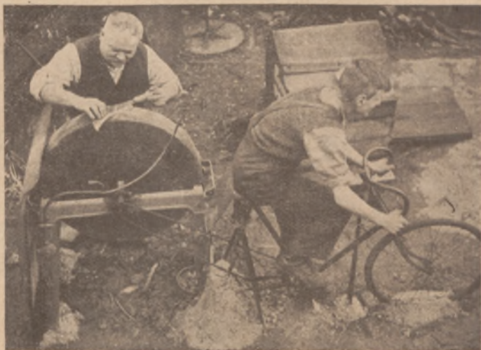
Pomysłowa instalacja „energii pędnej”.
