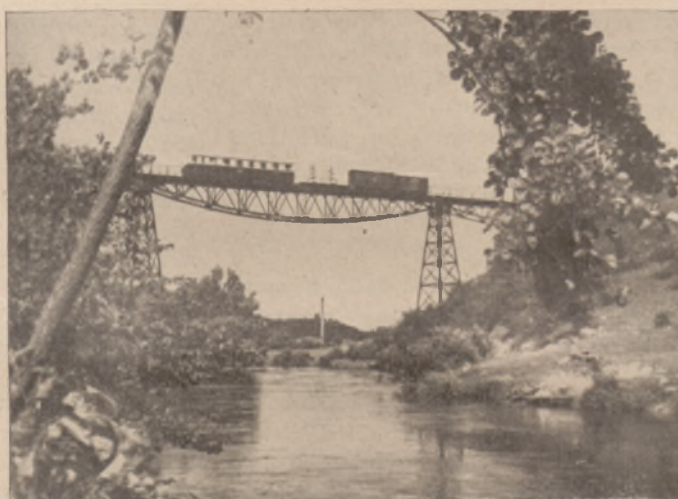
Most stalowy pod Koronowem.
