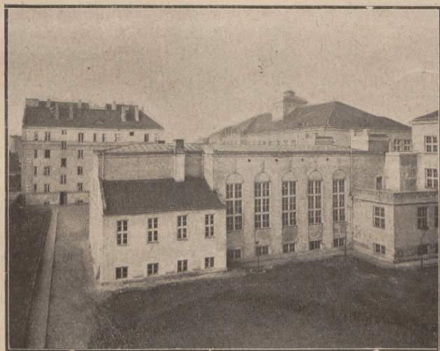
Szkoła przy ul. Otwockiej.
