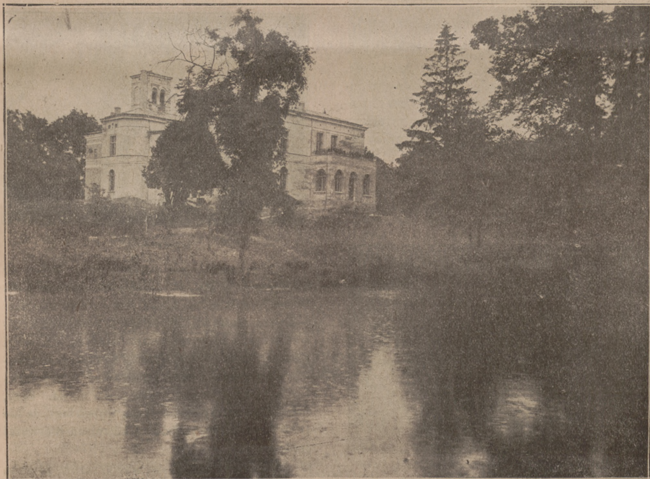
Internat i szkoła mleczarsko-serowarska w Szafarni.
