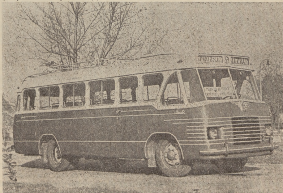
Fot. 8. Prototyp autobusu STAR-50 z metalowym nadwoziem
