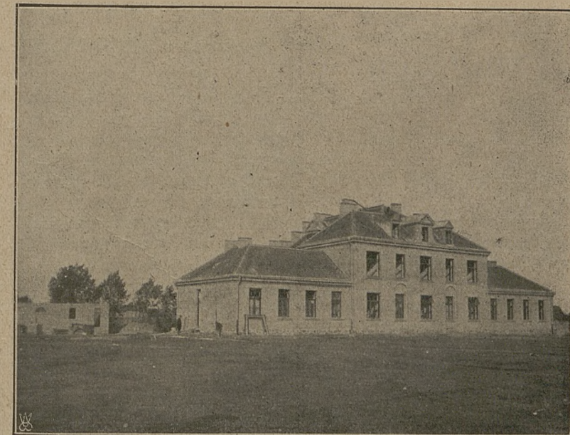
Špital Sejmikowy w Sierpcu w budowie.
