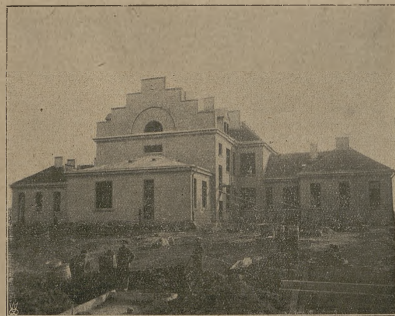
Fragment budowy Szpitala Sejmikowego w Sierpcu.
