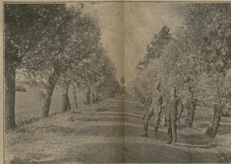
Przez bagno na drodze Raciąż — Kodłutowo usypano szosę żwirową w 1924 roku; długość żwirowki 32 km. Próba pierwsza w powiecie wypadła pomyślnie; żwirowka dotychczas dobrze się trzyma. Konserwacja tańsza niż szosy bitej kamiennej.
