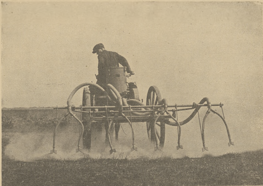
Rys. 1. Rozpylanie insektycydów przez wyloty opylacza (Do art.: „Metody zwalczania pewnych szkodników buraków cukrowych”)
