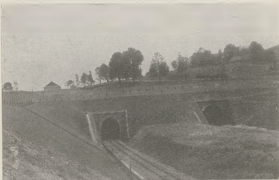
17. Wejście do tunelu pod przełęczą Jabłonkowską od str. północnej.
