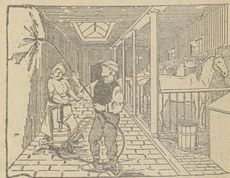
Bielenie ścian i sufitu w stajni bez rusztowania.
