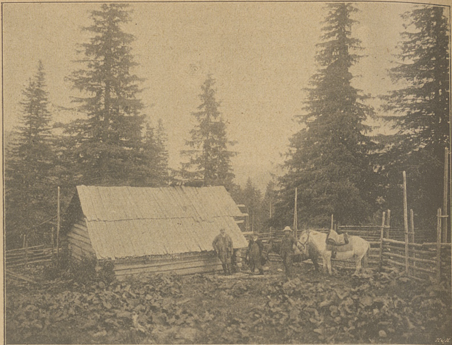
Fig. 7. Staje na Bukowince, otoczone szczawiem alpejskim.
