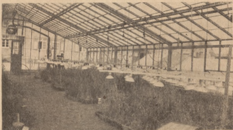
Halle — Szklarnia w Zakładzie Hodowli Roślin Uniwersytetu.
