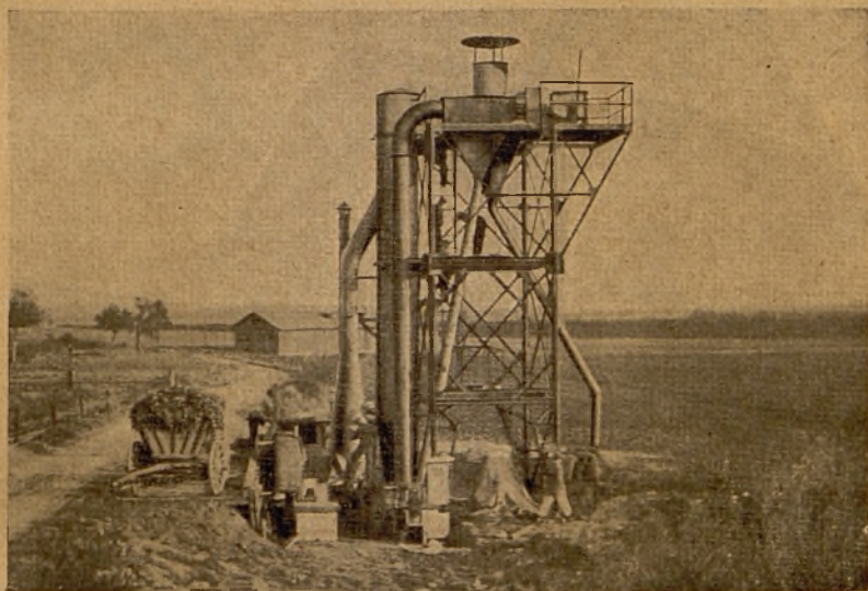
Fig. 14. Suszarnia mechaniczna syst. Rema-Rosin, suszarnia ta przerabia na godzinę 12,5 q. m. zielonej masy. Jest to najmniejszy model suszarni tego typu.
