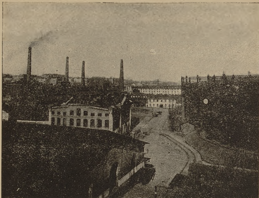
Widok ogólny gazowni I na Ludnej.
