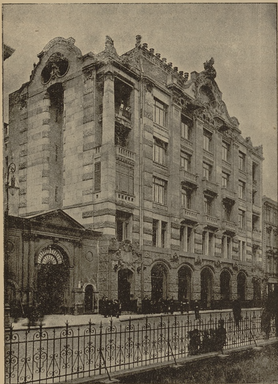
Gmach Dyrekcji Warsz. Zakładów Gazowych przy ul. Kredytowej 3.
